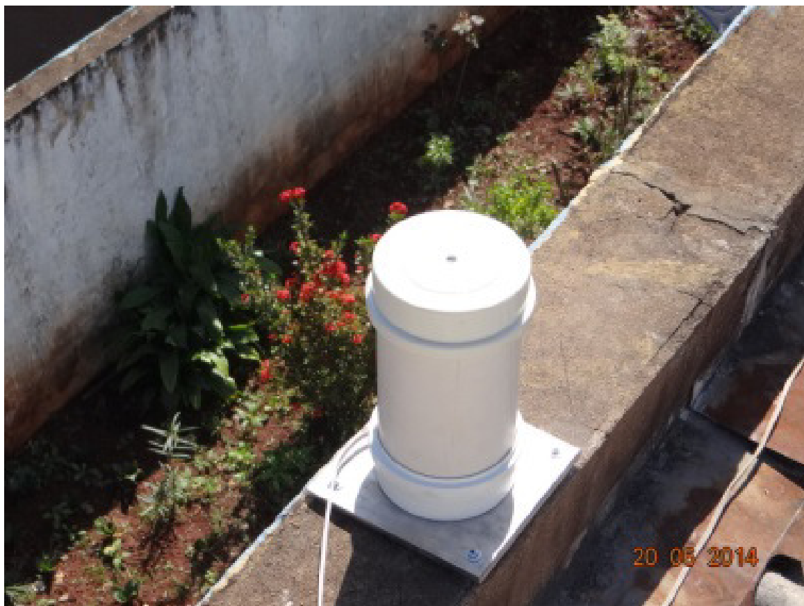
Figura 4.4 - Equipamento instalado sobre uma base de alumínio parafusada numa viga do telhado.
